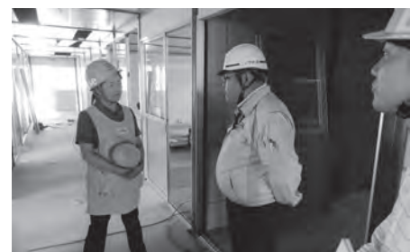
被災状況調査（益城町第五保育所仮設園）
