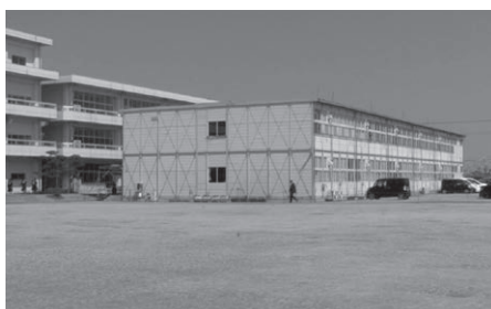
鹿島小学校の校庭に設置された南相馬市立小高中学校仮設校舎：震災前の3分の1程度の100人弱の子どもたちがここで学ぶ。
