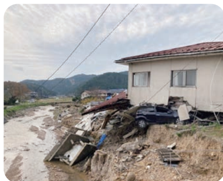
地震と豪雨の影響による被害(2024年11月時点の写真)
